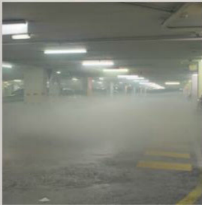
De la fumée dans le parking.
