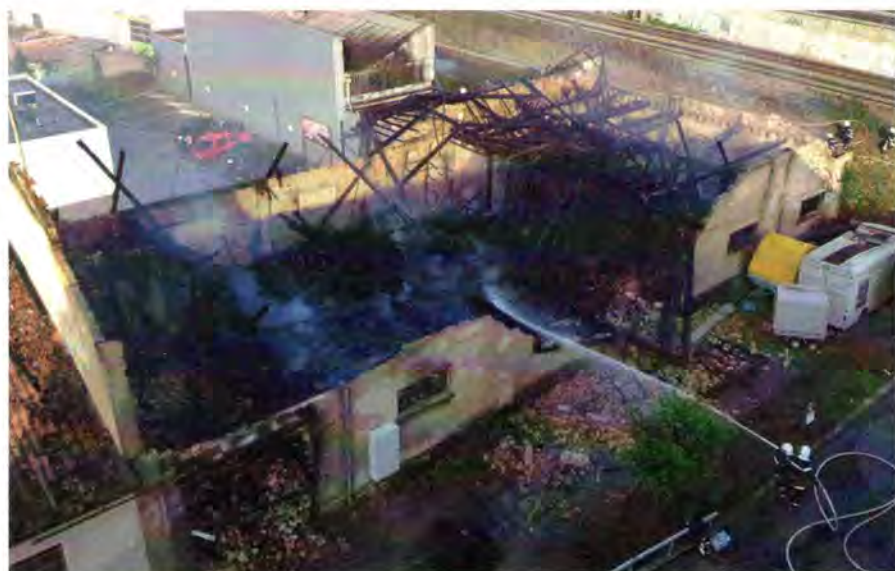
Même en présence d'une charpente en bois, une prudence extrême reste de mise: le danger d'un effondrement imprévu guette toujours.
